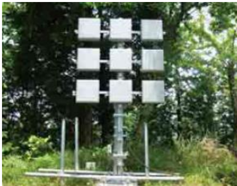
▲中継局間での電波の授受用のアンテナ
