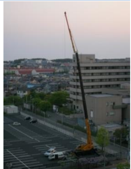
▲クレーン車での空中線設置
