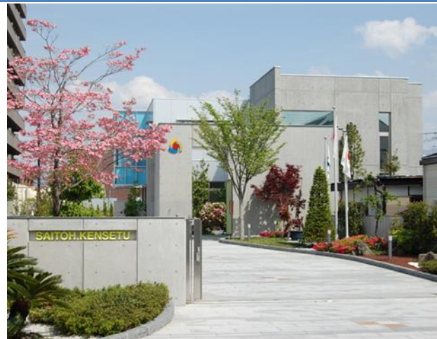
▲ 齋藤建設本社 外観
