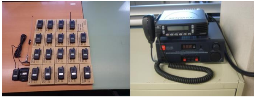
▲ 整備した防災無線
