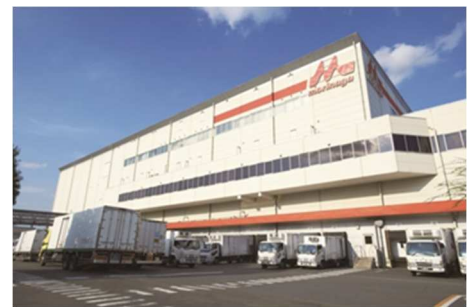
▲森永乳業 東京多摩工場
