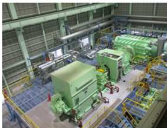
▲排熱発電設備 タービン発電機
