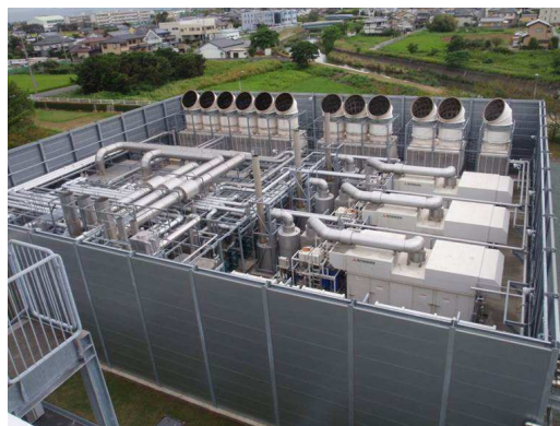
▲ガスコージェネレーション設備
