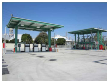
▲杉戸燃料備蓄基地の外観
