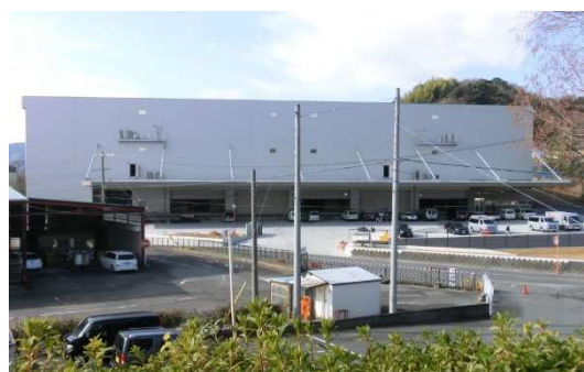
▲ 高台移転した静岡物流センター
