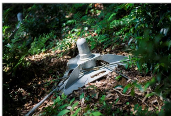
▲ ノンフレーム工法
