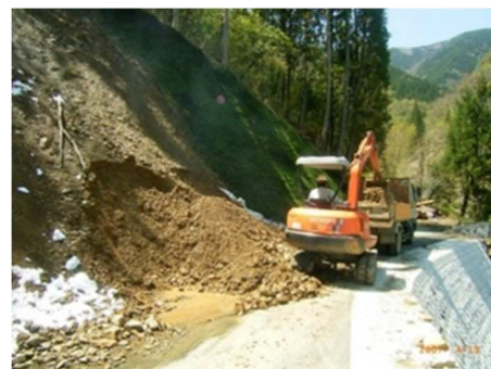
▲土砂崩れ現場での作業
