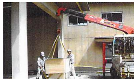
▲パーティション資材の荷下ろし
