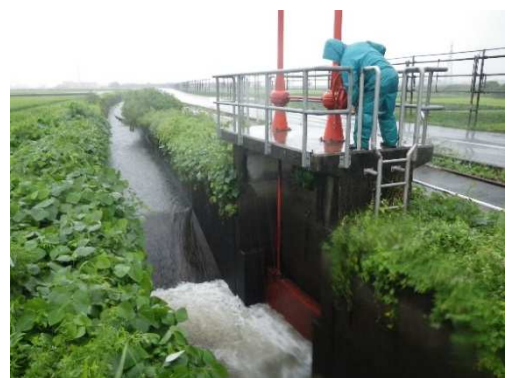
▲東二号幹線用水路の柴落余水吐
