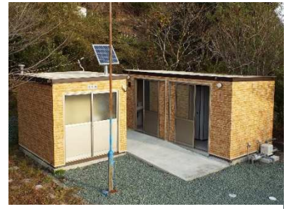
▲循環サイクルトイレ外観
