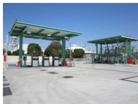
▲杉戸燃料備蓄基地の外観
