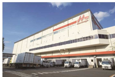
▲森永乳業 東京多摩工場
