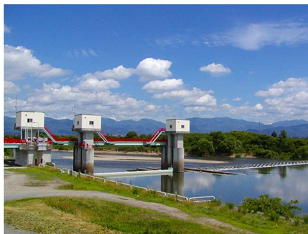
▲最上川から農業用水を取水する三郷堰頭首工
