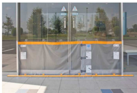
▲止水シートの設置
