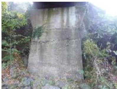
▲橋梁 ひび割れ補修施工前
