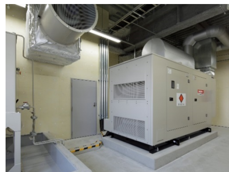
▲非常用発電機
