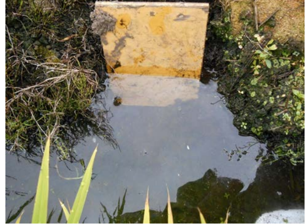
▲止水板による止水状況
