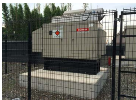
▲同ミュージアムの 非常用長時間型防災用発電機化器機
