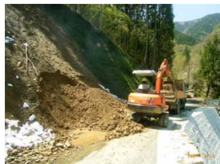
▲土砂崩れ現場での作業
