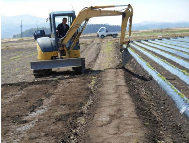
▲バックホーによる復田の畦畔高上げ
