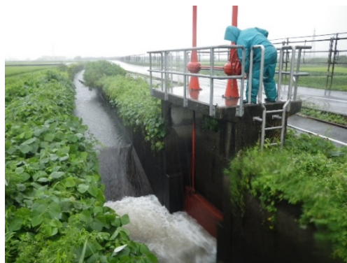
▲東二号幹線用水路の柴落余水吐
