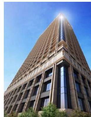
▲東京日本橋タワー 外観
