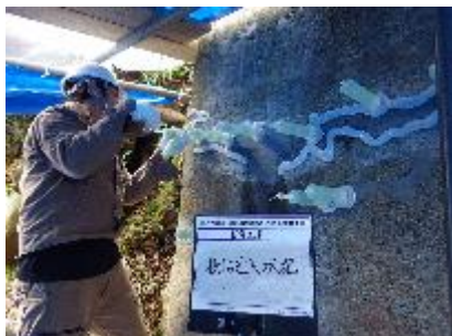
▲樹脂注入の様子
