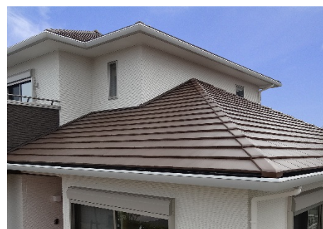
▲洋風防災瓦の施工例
