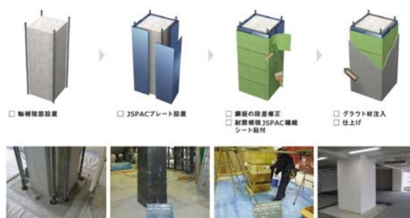
▲JSPAC 耐震工法の施工の様子
