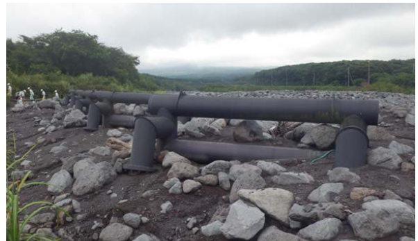
▲遊砂地内に設置された小型鋼製砂防構造物
