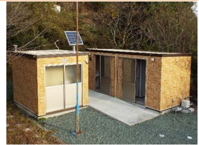
▲循環サイクルトイレ外観
