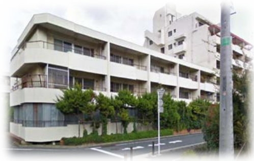
▲耐震補強工事施工前
