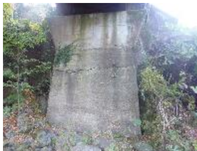
▲橋梁 ひび割れ補修施工前
