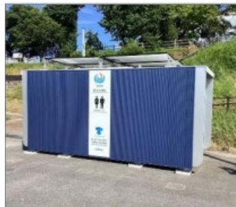
図 平常時の設置(道の駅「うきは」)
