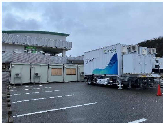
▲ 志賀町立富来病院に設置された医療コンテナ
