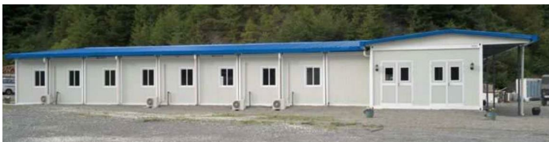
図4-1 岩手県立大槌病院に導入されたフラットパックコンテナ
