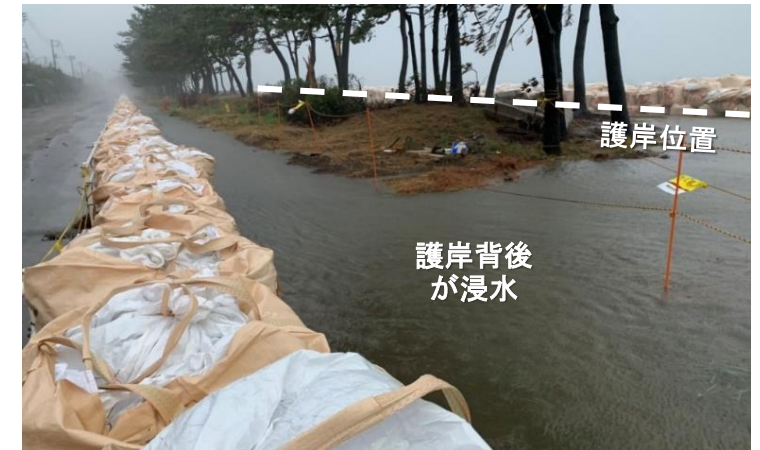
横浜港の浸水被害状況(令和元年台風19号)
