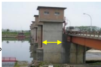
耐震化前の頭首工堰柱
