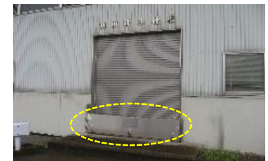
耐水扉の設置
