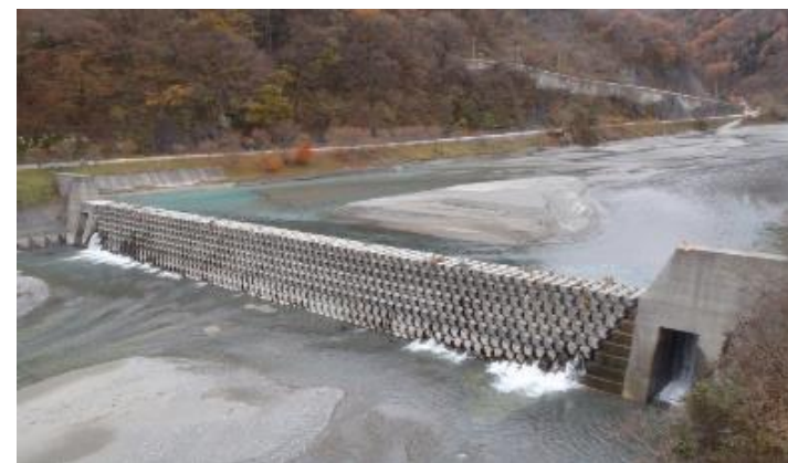
貯砂ダムによる土砂流入の低減
