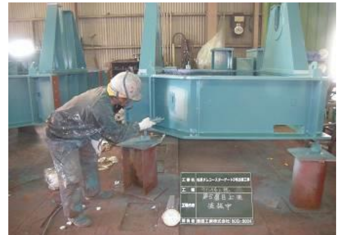
塗装による機械設備の補修
