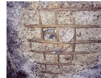
コンクリートが腐食し、鉄筋が露出した管路施設 管路の劣化の例
