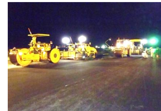
老朽化した滑走路舗装の改良
