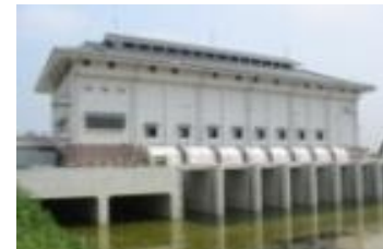
排水機場の改修
