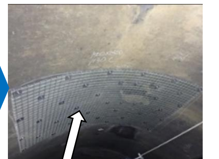
繊維シート貼付
