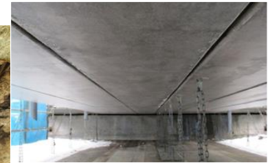
床版打ち換え
