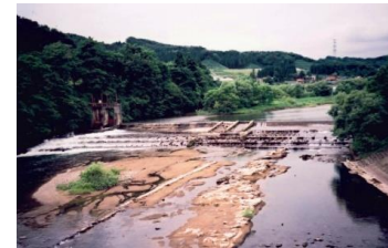
改修前の頭首工
