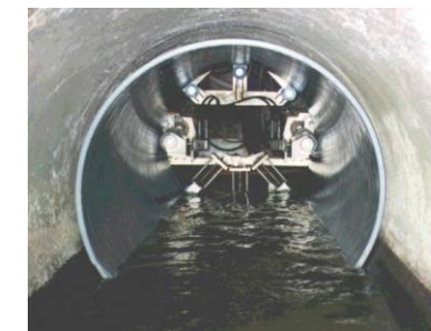
更生工法による老朽化対策
