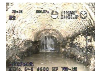
コンクリートが腐食し、鉄筋が露出した管路施設 管路の劣化の例
