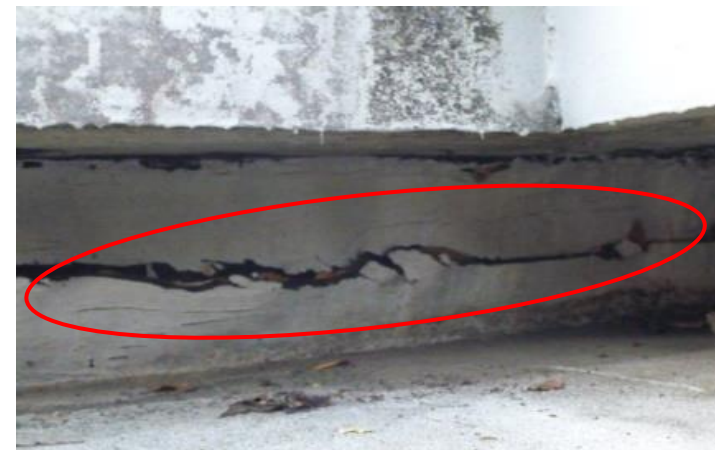
劣化が進む各施設の防水対策工事を行い、安全・安心な施設設備の充実を図る。
