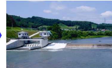
改修後の頭首工
