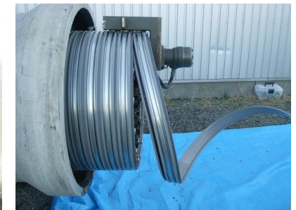
更生工法による老朽化対策
