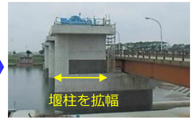
耐震化後の頭首工堰柱
