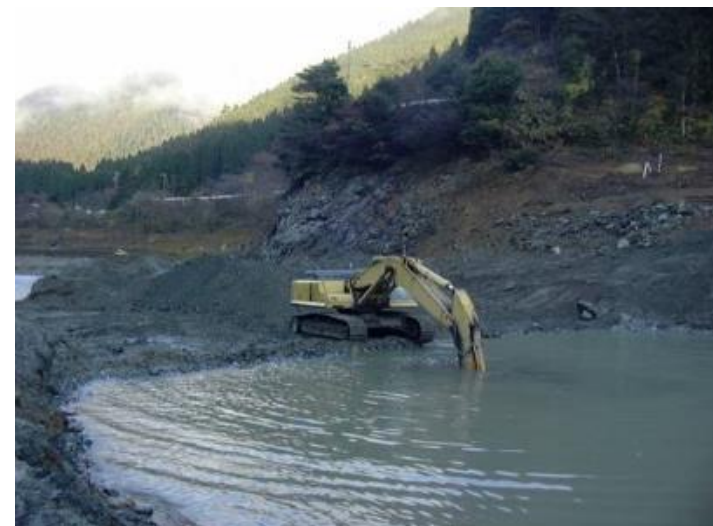
堆砂掘削による土砂等の撤去
