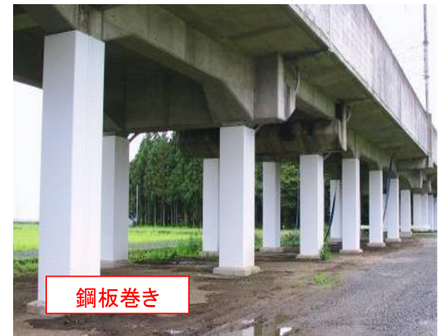
鋼板巻きによる耐震補強
