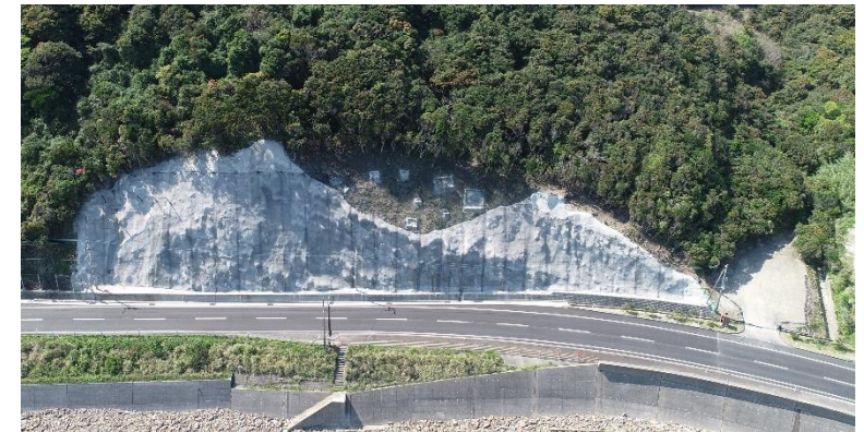
法面吹付工、落石防止網工
