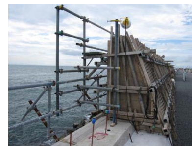
既存護岸の嵩上げ
