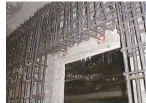
処理場の耐震化（躯体補強）
