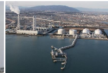
大型タンカーバース
