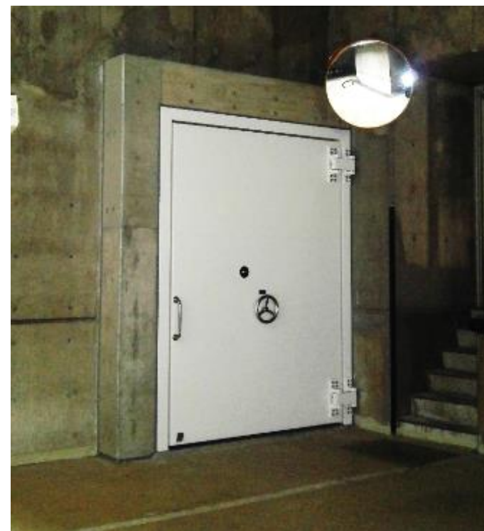
止水扉の設置
