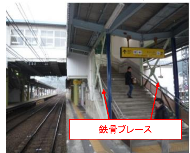
鉄骨ブレースによる耐震補強
