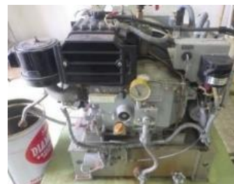
老朽化発電機の換装
