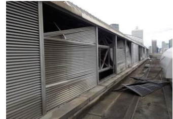
平成30年台風21号 による暴風被害 (機械室壁面の被害)
