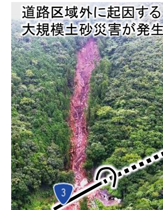
道路区域外に起因する 大規模土砂災害が発生 令和2年7月豪雨 (14日間の通行止め)
