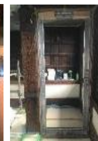
鉄骨フレーム
