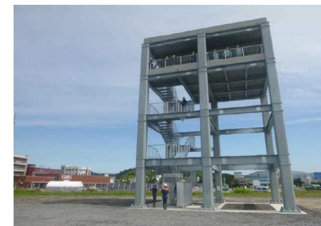
津波避難タワー
