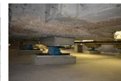
免震装置設置
