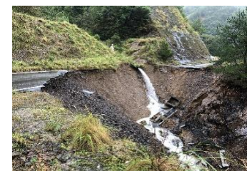
災害に備えた林道の改良整備
