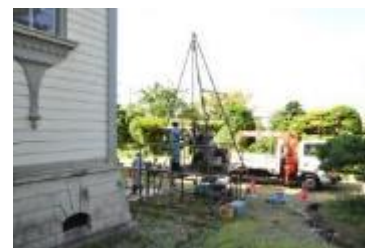
ボーリングによる地盤調査
