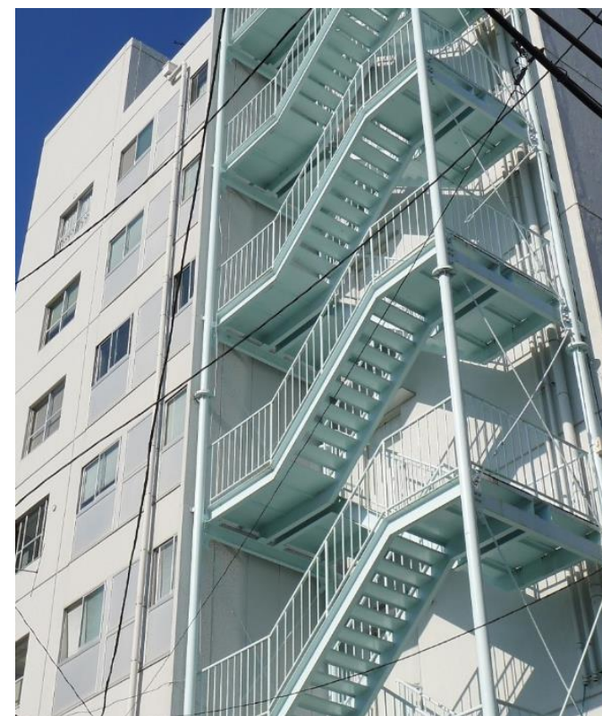
避難用外階段の改修
