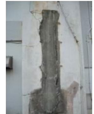
外壁、柱のひび割れ状況の例
