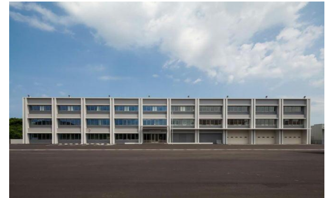
令和2年度に建て替え・長寿命化を図った 島根県警察機動隊庁舎
