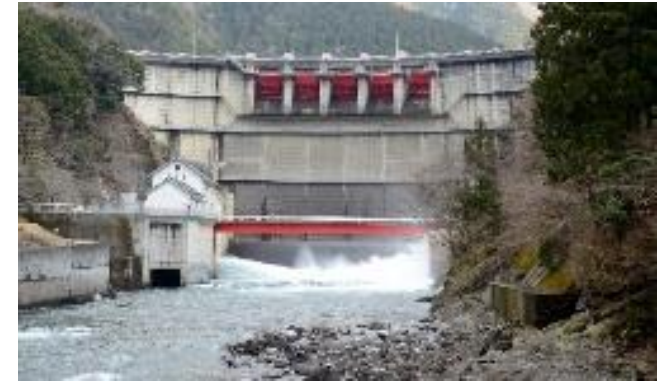
農業用ダムの堆砂対策による貯水容量の確保や洪水調節機能の強化に資する施設整備
