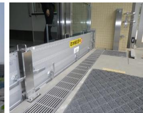
止水板の設置
