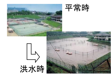
貯留施設の整備
