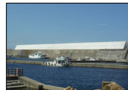
防波堤の嵩上げによる越波防止
