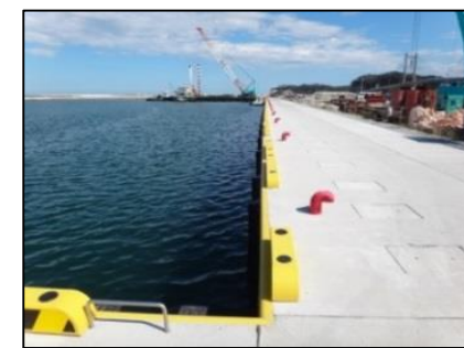
岸壁の耐震化による陸揚げ機能強化
