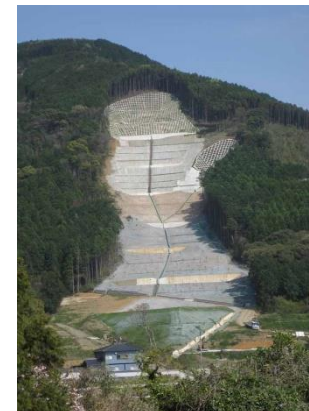
流木捕捉式治山ダムの整備による流木等の捕捉
