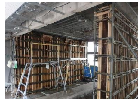
耐震補強壁の設置工事
