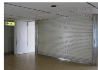
防火シャッター（建築基準法の 現行法規への対応）
