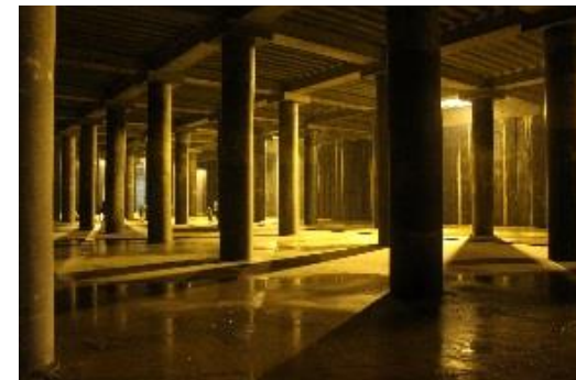
雨水貯留施設の整備
