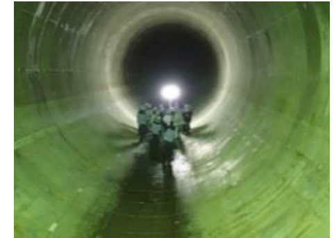
雨水貯留管の整備
