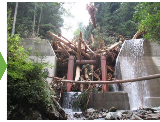
流木捕捉式治山ダムの整備による流木等の捕捉
