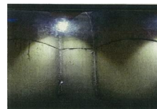
煙突内部表面 （煙突内アスベスト除去）
