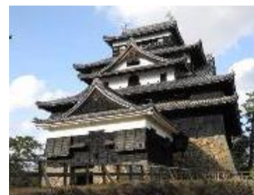
耐震補強: 松江城天守
