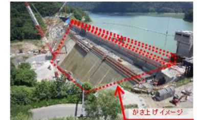
ダム建設・ダム再生
