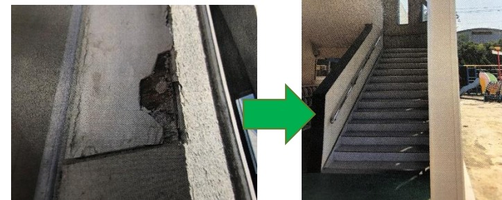
園舎外壁の不良部分を改修して耐震対策を図り、倒壊・剥落等を防止
