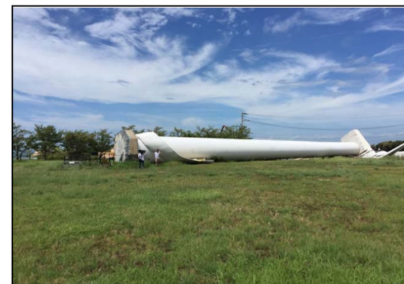
風力発電設備の倒壊事故
