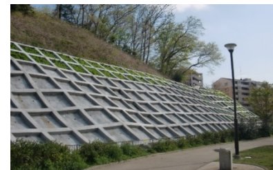
法面崩壊対策イメージ
