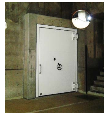
<止水扉の設置>
