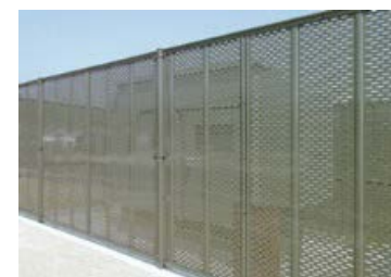
既設ブロック塀等を撤去し、フェンス等を新設
