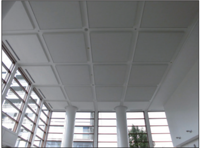
天井耐震対策後
