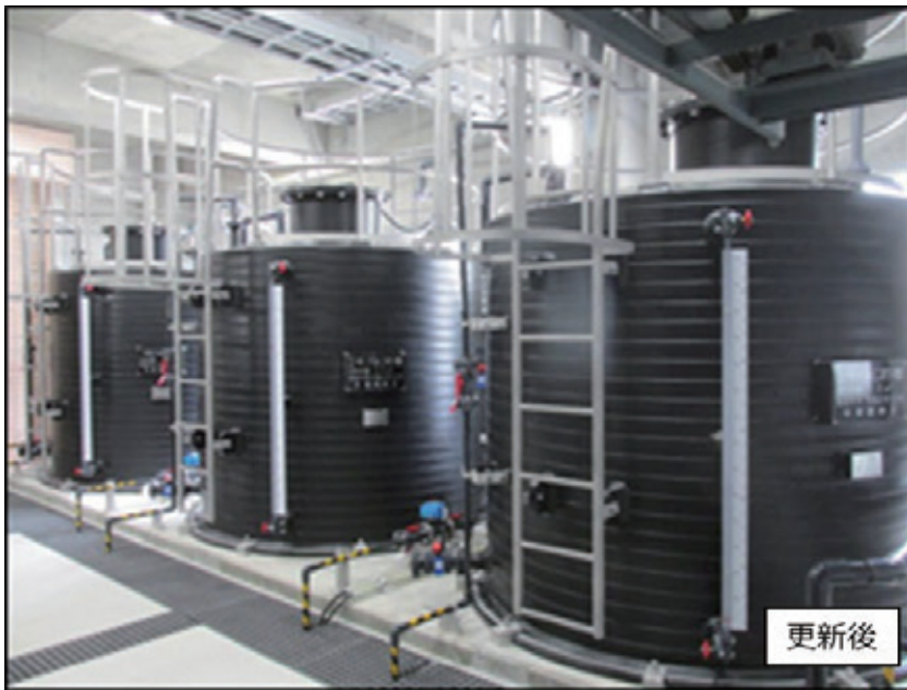
更新した白島浄水場の薬注設備。 河川水を浄化するため薬品を注入する設備。
