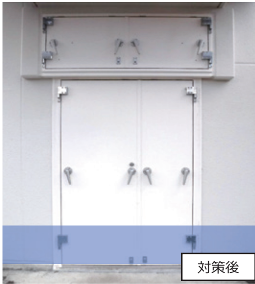
止水扉（水源地の建屋内にある電気設備等の浸水対策として設置）
