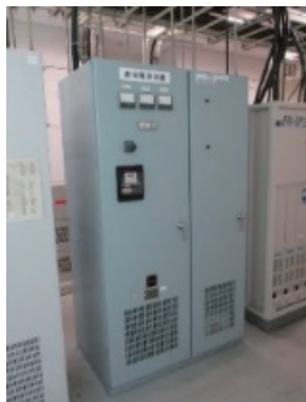
警察通信の維持のために更新した無線中継所の非常用電源設備
