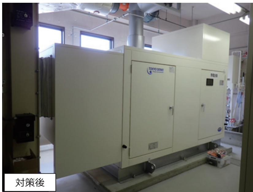
盛岡地方気象台に整備した自家発電設備
