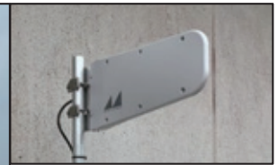
バックアップ回線 (LTE回線)用アンテナ
