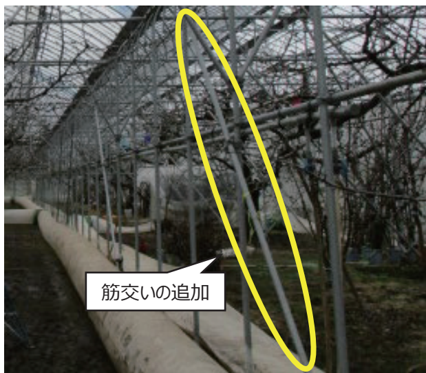
農業用ハウスの補強対策実施済み
