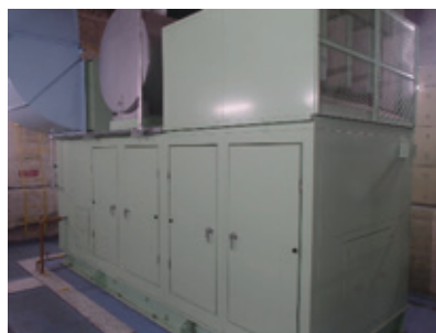
非常用発電設備の設置
