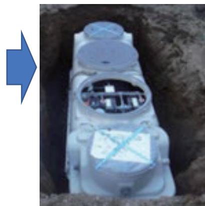
合併処理浄化槽への転換
