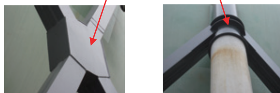
球形貯槽を支える脚部の補強対策
