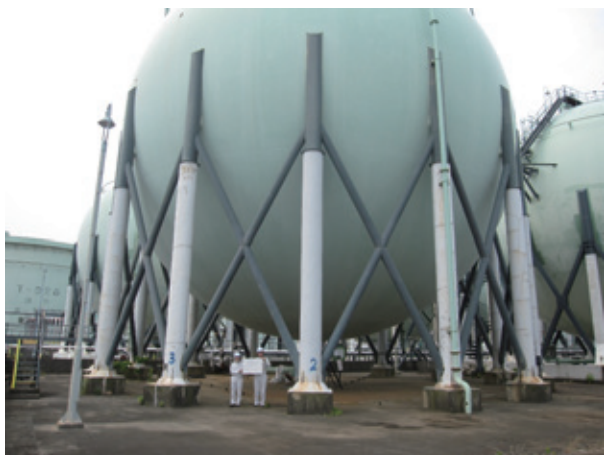
球形貯槽（耐震補強前）
