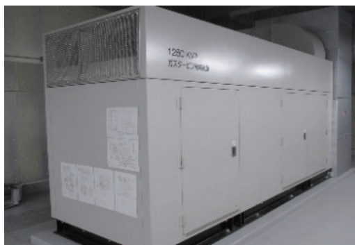
冷蔵施設に非常用電源を整備
