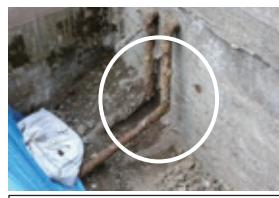
腐食により燃料供給が途絶するリスクのある配管
