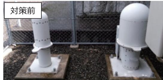
電源系統の劣化による欠測、指示値不良、検出器の分解能の低下等が発生していました。
