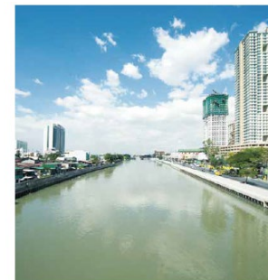
改修を行ったバッシング・マリキナ川 (フィリピン)
