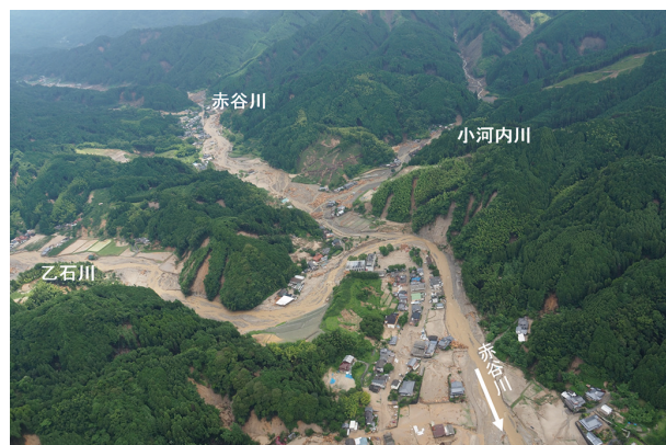
図21 2017年の九州北部豪雨による被害（福岡県朝倉市の赤谷川、小河内川、乙石川合流点付近における流木による被害） 出典19より
