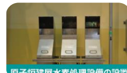
原子炉建屋水素処理設備の設置
