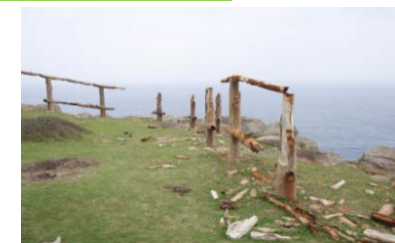
(老朽化した落下防止柵の再整備)
