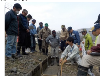
水路補修工法技術の出前授業
