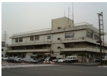
老朽化した警察施設
