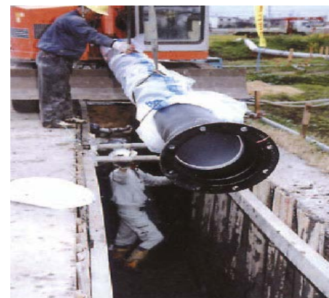
老朽管の更新工事
