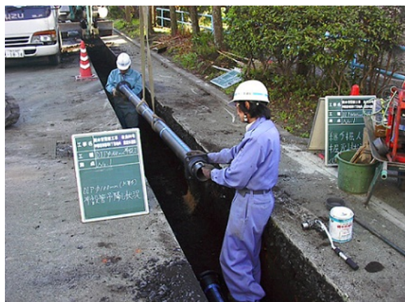
管路の布設工事
