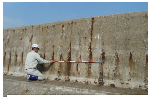
老朽化状況(コンクリート劣化・鉄筋露出)
