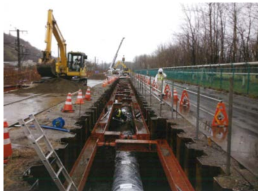
管の布設工事
