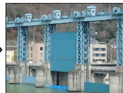
老朽化した施設(放流設備)の改良 (高耐候性塗料による再塗装)
