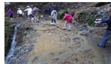
(利用が多い荒廃歩道の再整備)
