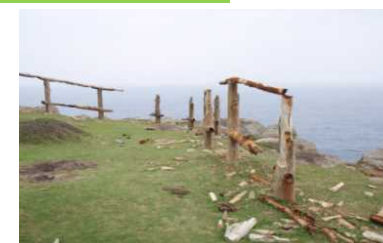
(老朽化した落下防止柵の再整備)
