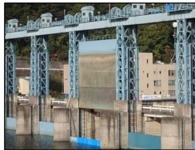
老朽化した施設(放流設備)の改良 (高耐候性塗料による再塗装)
