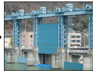
老朽化した施設(放流設備)の改良 (高耐候性塗料による再塗装)
