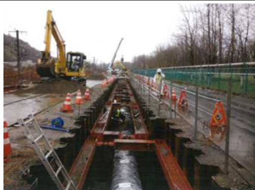
管の布設工事
