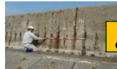
コンクリート劣化・鉄筋露出
