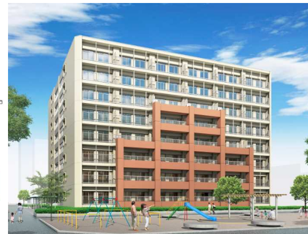
【整備イメージ】(外付フレーム補強のイメージ図)
