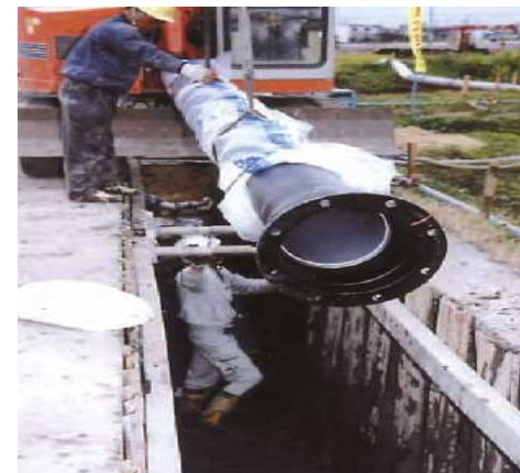
老朽管の更新工事
