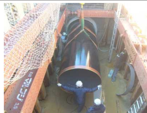
管路の更新工事(老朽管内に新管の挿入)
