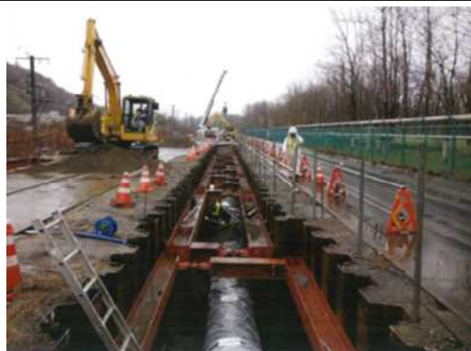
管の布設工事
