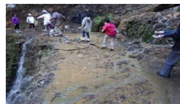
(利用が多い荒廃歩道の再整備)
