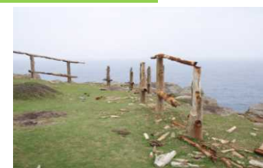
(老朽化した落下防止柵の再整備)
