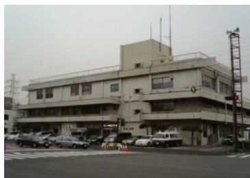
老朽化した警察施設
