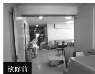
老朽化した製図室
