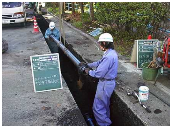
管路の布設工事
