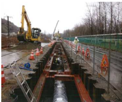
管路の布設工事
