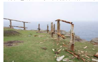
(老朽化した落下防止柵の再整備)
