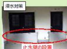
止水壁の設置
