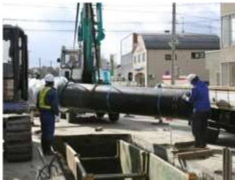
老朽管の布設替工事
