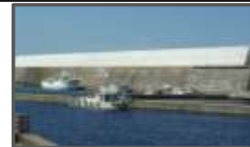
防波堤の嵩上げによる越波対策
