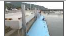
陸揚げの軽劣化に資する浮体式係船岸の整備
