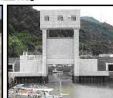
津波・高潮対策としての水門整備
