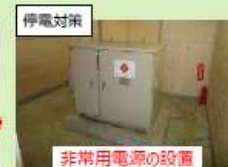
非常用電源の設置
