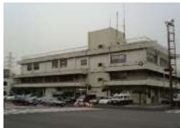
老朽化した警察施設
