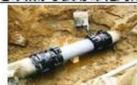
漏水防止のための整備
