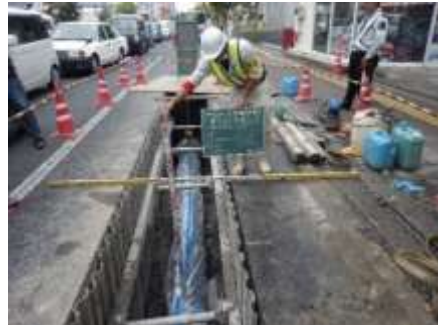
管路の布設替（開削工）
