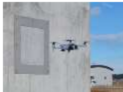
ドローンによる損傷把握
