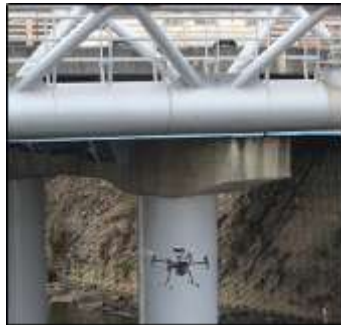
水管橋の点検
