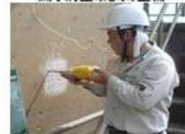
老朽化した施設の機能診断
