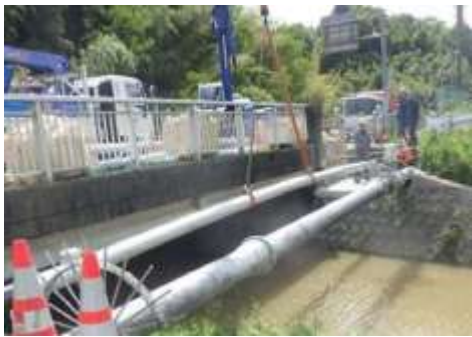
水管橋の更新工事
