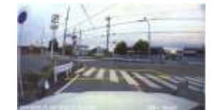
ドライブレコーダーで取得した画像による区画線の摩耗判定
