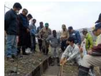
水路補修工法技術の出前授業
