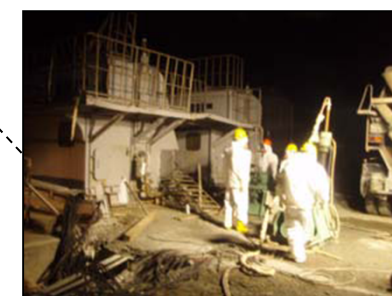
薬液注入時写真 (4/5東京電力撮影)
