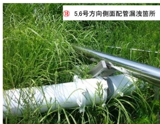
⑱ 5.6号方向側面配管漏洩箇所 平成23年8月15日 東京電力撮影
