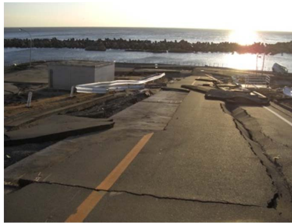
道路補強工を実施した箇所であるが、補強していない道路両脇に割れ及び段差が発生。 「平成23年3月17日 東京電力撮影」
