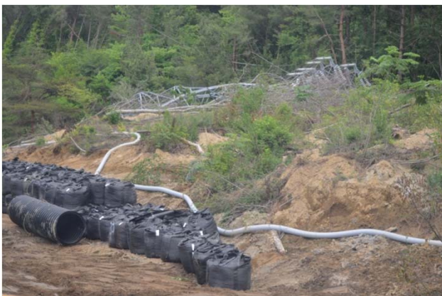
福島第一原発5、6号機に電力を供給する 「夜の森線」で地震により倒壊した鉄塔
