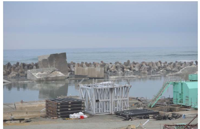
福島第一原発6号機取水口付近の防潮堤残骸 (津波で高さ10mの防潮堤が倒壊し、テトラポットのみが残されている)
