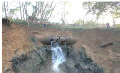
・水道管破損による土砂流出
