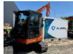
欧州における可搬式充電設備の販売・レンタルの例
