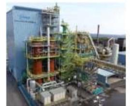
12m<sup>3</sup> 小規模試験高炉(水素還元)
