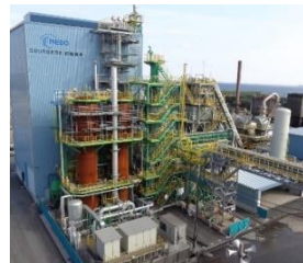
12m 3 小規模試験用高炉(水素還元)
