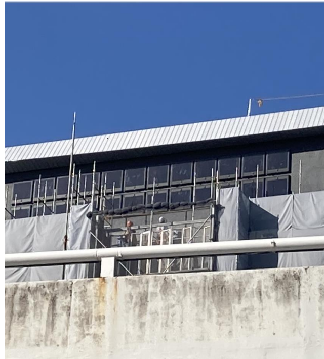
建物壁面への実装工事の様子
