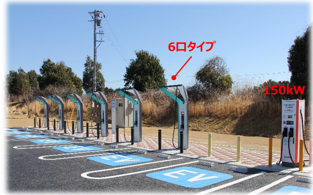
浜松サービスエリアに設置された高出力・複数口の充電器
