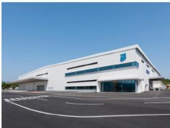
埼玉工場 新建屋外観
