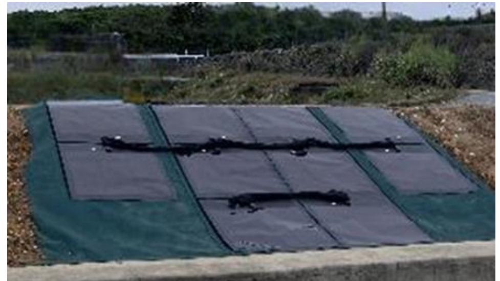
設置完了したフィルム型ペロブスカイト太陽電池
