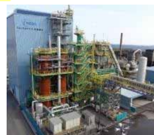
12m 3 小規模試験高炉(水素還元)
