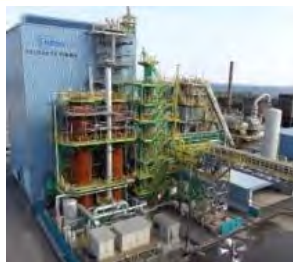
12m 3 小規模試験高炉(水素還元)
